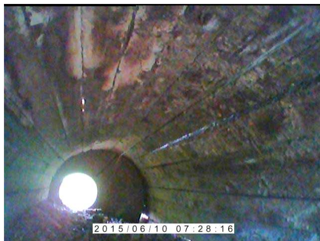
Die an beiden Enden offene Steinkauzröhre ist als Quartiere für Fledermäuse ungeeignet.
